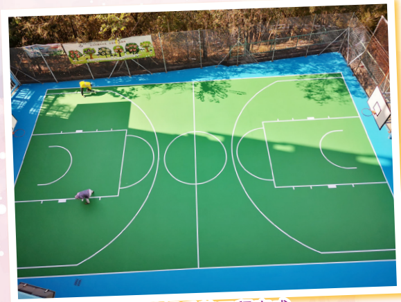
籃球場重整工程完成
