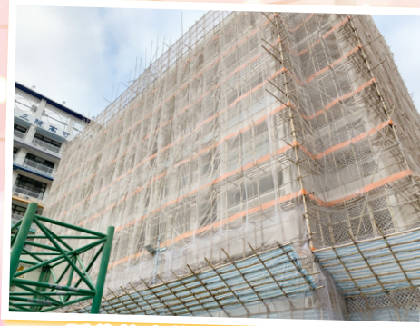
延伸校舍的外牆及內部翻新工程進行得如火如荼
