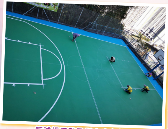
籃球場平整及髹上底色後，技工正為它添上清晰的界線
